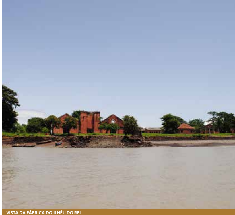
VISTA DA FÁBRICA DO ILHÉU DO REI
