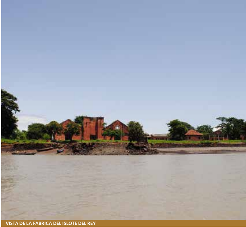
VISTA DE LA FÁBRICA DEL ISLOTE DEL REY
